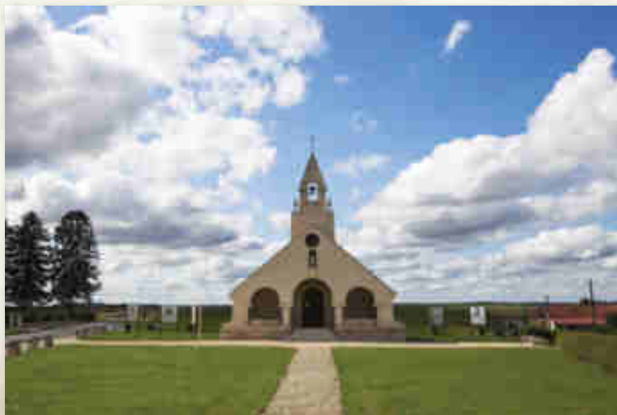
▲ Chapelle mémorial du Chemin des Dames à Cerny-en-Laonnois.
