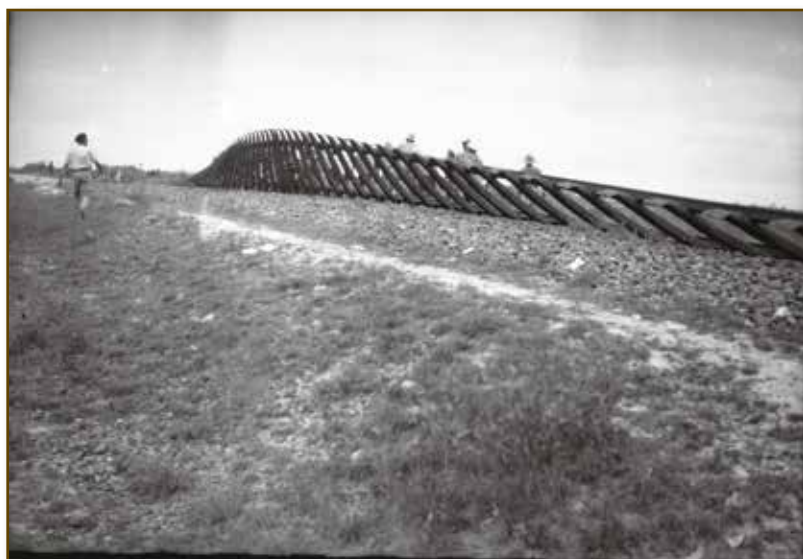
En 1951, portion de voie retournée en un point en mobilisant les villageois, la force d'inertie entraînant la bascule de tout le reste du segment.
