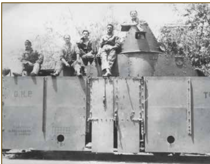
Wagon blindé au Levant, construit autour d'une automitrailleuse White-Laffly.
